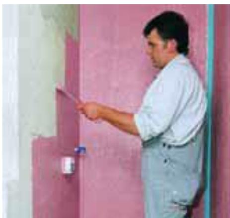
Нанесение первого слоя красной гидроизоляции MasterTile WP668.
