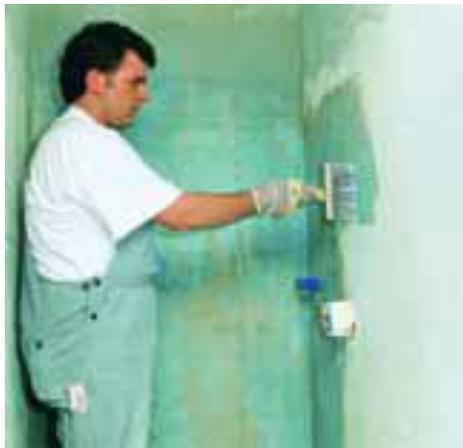
Нанесение грунтовки MasterTile P302 на непитывающие и гипсовые основания.
